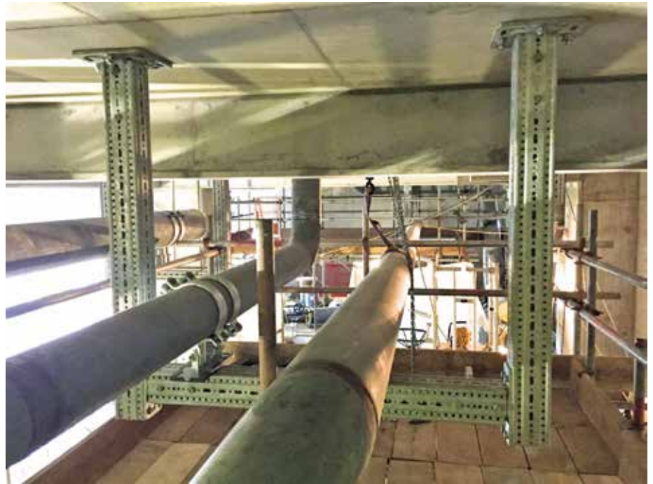
Abbildung 2: Zweidimensionale typische U-Jochkonstruktion
