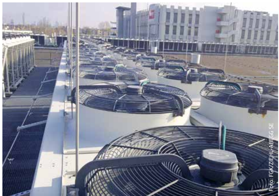
Abbildung 4: Rückkühler mit AC-Technologie vor der Modernisierung
