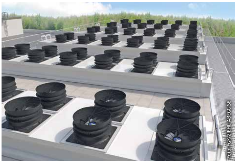
Abbildung 5: Rückkühler mit effizienter EC-Technologie nach der Modernisierung
